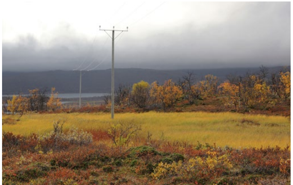
Rovakairan Verkonrakennuksen päätoimiala on sähkö- ja televerkkojen rakentaminen ja kunnossapito.
